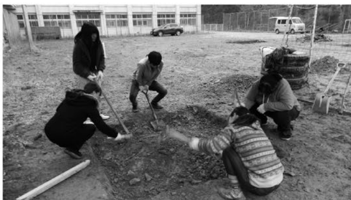
図表3 石窯の基礎工事をを行う学生たち（出所：筆者撮影）
