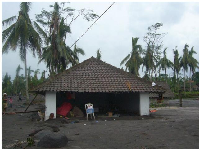
図 5-10 土石流により土砂に埋まった家屋
