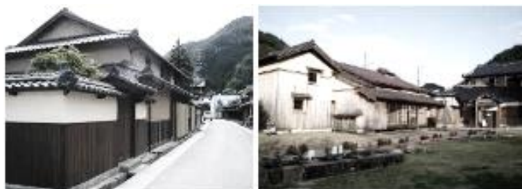
図 25. (左) 生野まちづくり工房「井筒屋」 (右) 口銀谷・銀山町ミュージアムセンター
