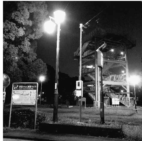
図5 静岡県富士市「鈴川港公園津波避難タワー」
