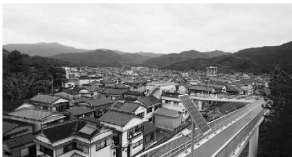
図4 街中の駐車場所へ延びるスロープ
