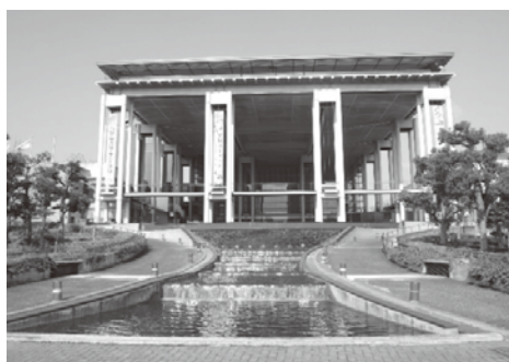
南海浪切ホールの2Fに岸和田サテライトを設置
