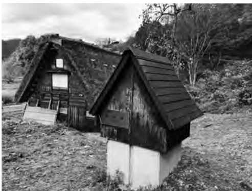
図 4. 放水銃 (写真右側の建造物)(筆者撮影)
