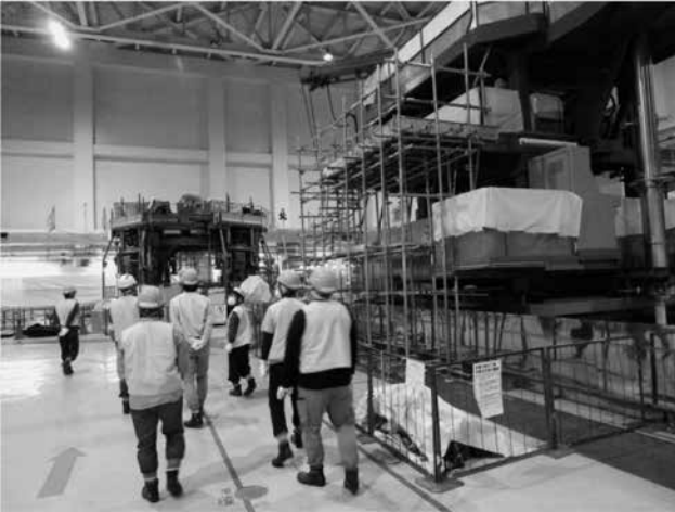
図7 5号機最上層のオペフロ見学中。写真右側のものは燃料棒を移動させるクレーン。(東電提供)
