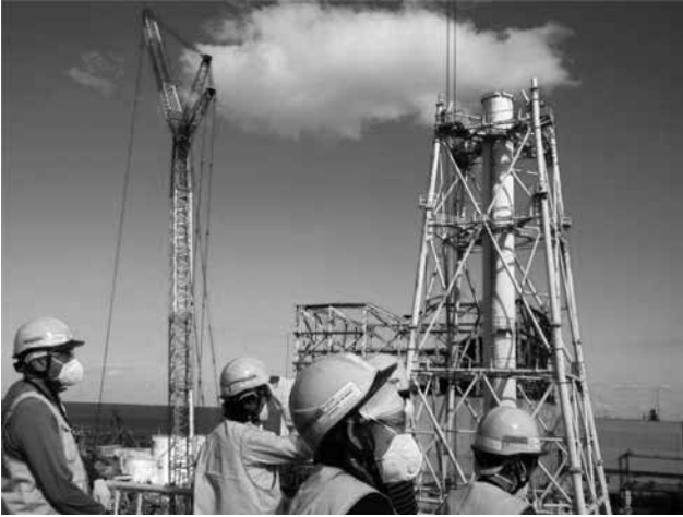
図3 「高台」での見学の様子。右に解体工事が終了し短くなった1/2排気筒、その向こうに1号機が見える。(東電提供)
