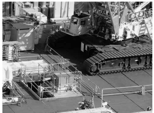
図5 2号機付近で作業をするクレーン車。大きい。「のぞみ」のプレートが目を引く。
