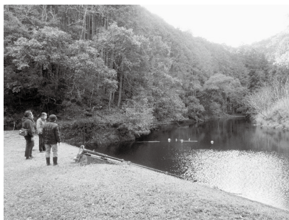
写真1 改修後のため池（西川地区、2023年3月撮影）
