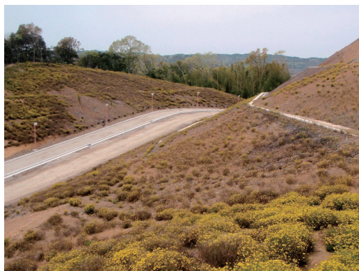
図1 2010年4月18日撮影の対象切土部
