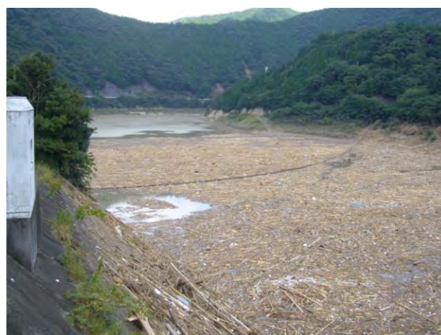
図-1 ダム流木(椿山ダム, 2011年9月撮影)
