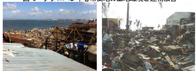
図-4 被災直後のスラム地区
